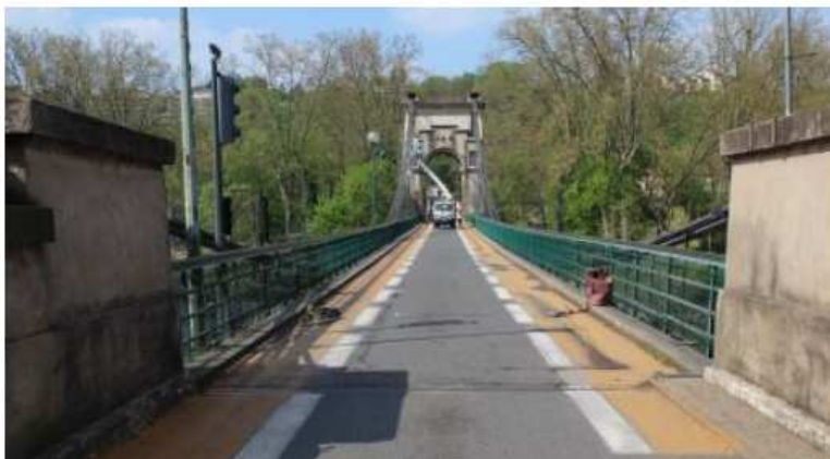
Travée rive droite
